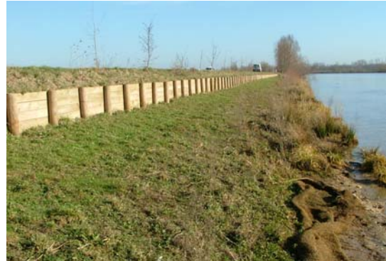
Protection par risberme d'hélophytes sur la Saône. Le tunage dans ce cas ne sert qu'à gagner de la hauteur de berge (photo CETE Lyon)
