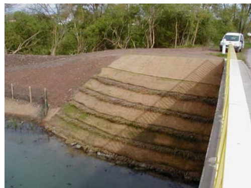
Travaux sur le canal de Colmar
