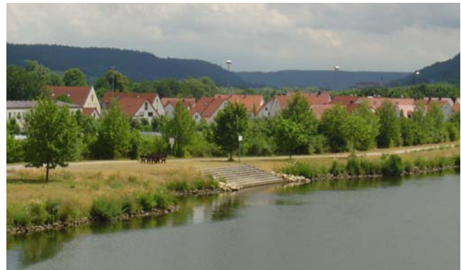
Canal Main-Danube (Allemagne) : le chemin de service est légèrement décalé pour laisser place à une aire de loisir.
